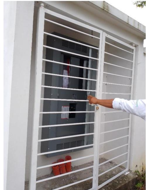
**Actividades Realizadas:** Suministro y colocación de transformador pedestal, elaboración de base para transformador de pedestal para registro de media tensión con tapa y construcción de nicho de medición. Se tiene montado el tablero interruptor. Se está realizando la zanja para alojar los tubos PAD, pero ya no ha vuelto la empresa. También están detenidos los trabajos de la rampa de acceso.
